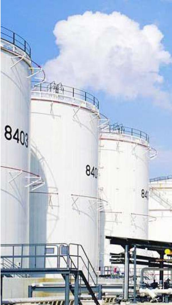
2.- Hay descarga de producto (vaciado) o condensación por baja temperatura del medio ambiente y se debe compensar ese vacío existente, por medio de entrada controlada de aire del exterior.
