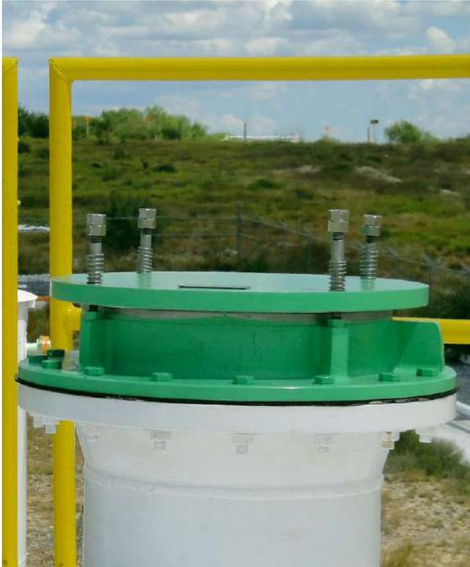
El mantenimiento de las ventilas , se inicia en el desmontaje de la ventila y su desarmado, para limpiar el diafragma, revisar el asiento y si es necesario rectificarlo, cambiar el empaque, ya revisados los componetes de sello, se procede a su armado, para posteriormente colocarlo en el banco de pruebas para checar su calibracion (para asegurar que es correcta).
