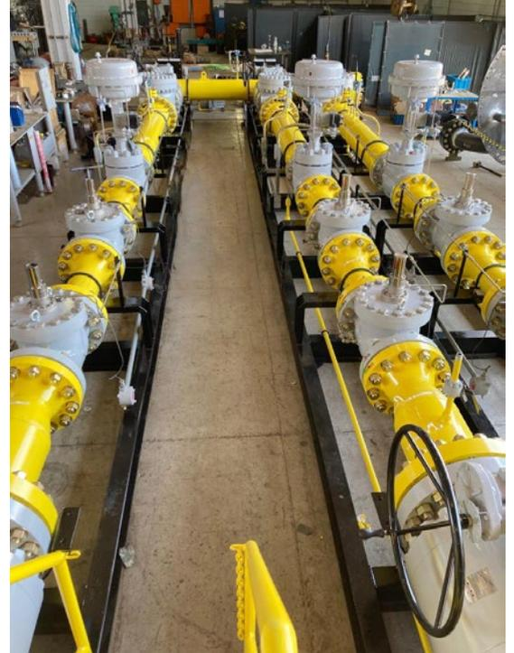
Módulo de Regulação de Pressão para alimentação de Usina Termelétrica a partir de GNL, com capacidade para 200.000 Nm<sup>3</sup>/h. Composto por 3 tramos (3 x 50%), sendo dois em operação e um em espera; cada um equipado com válvulas de: esfera manual, controle de pressão, bloqueio automático por aumento ou queda de pressão, alívio parcial e retenção.
