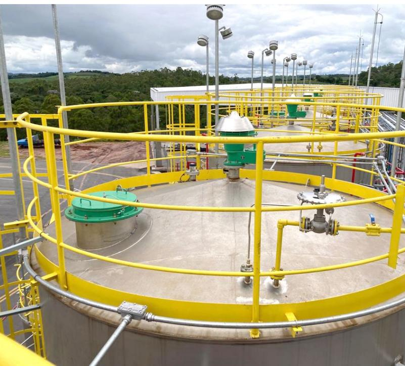
Este sistema tem como finalidade proteger os tanques de armazenagem de fluidos inflamáveis e degradáveis, bem como o fluido armazenado.
